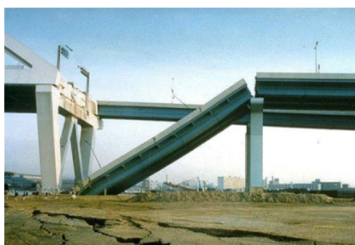
Gambar 2. Lepasnya Struktur Bangunan Atas Dari Pilar Jembatan
