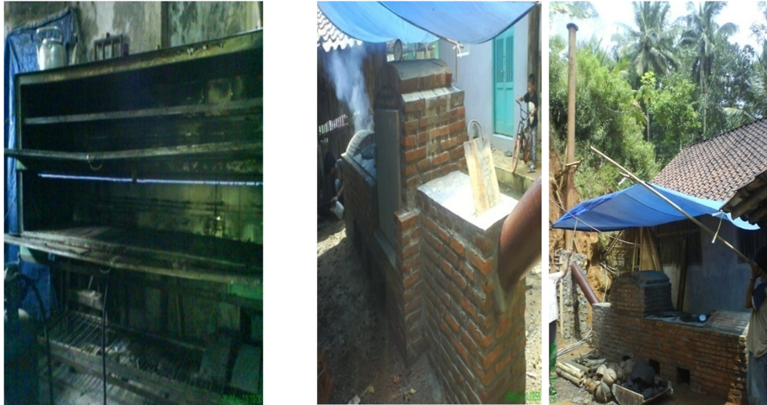
Gambar 3.2. Kegiatan retrofit dari model fisik tungku tradisional menjadi tungku perbaikan.
