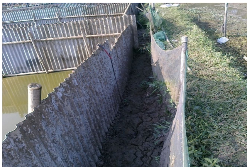
Gambar 3. Perbaikan tanggul kolam semi permanen dengan asbes gelombang
