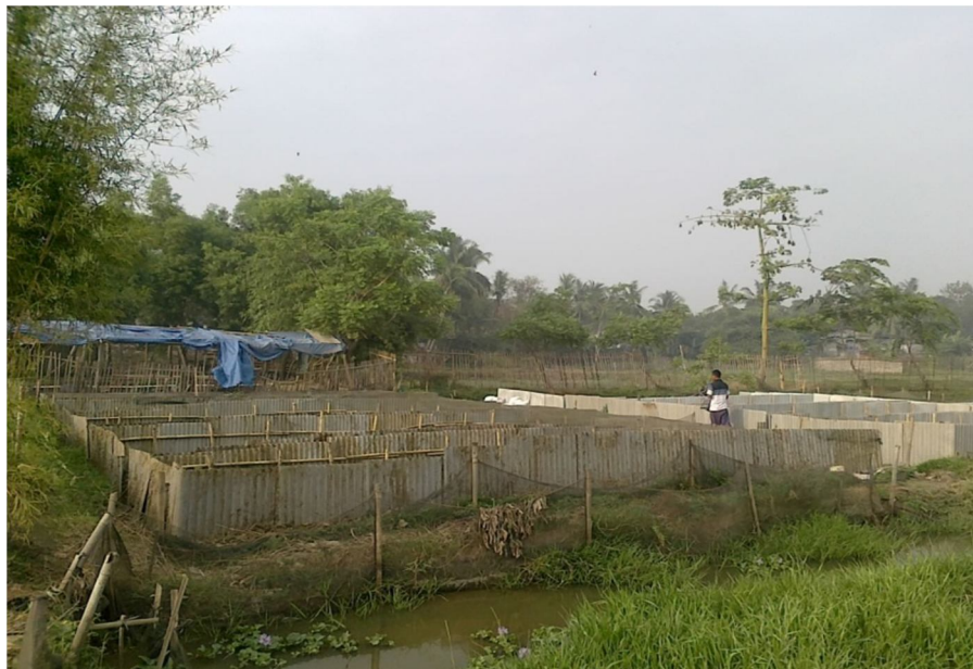
Gambar 5. Kolam lele setelah pemasangan asbes gelombang untuk tanggul semi permanen
