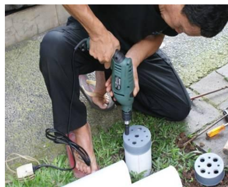
b) Tutup biopori menggunakan paralon yang dilubangi
