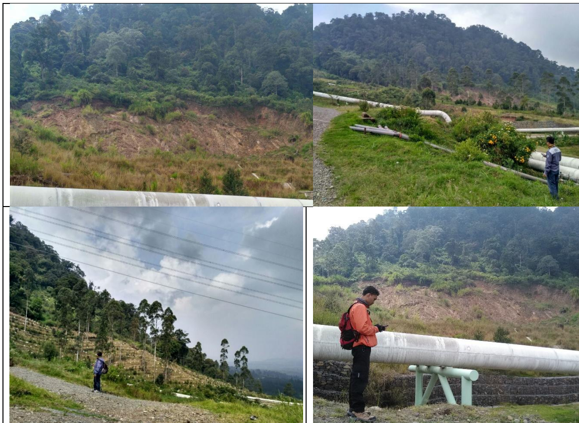
Gambar 5. Lereng dengan kerawanan sangat tinggi dengan kemiringan lereng terjal (35o-45o) dan sangat terjal (45-65o) terletak di daerah Cibitung.
